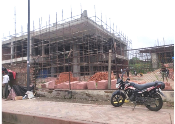
6.14: निर्माणाधीन संग्रहालय और फूडकोर्ट ब्लॉक का चित्र 6.14: Image of the under-construction Museum and Food Court Block
